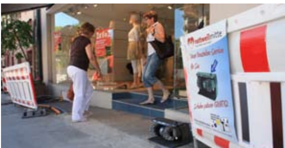
Ersatzleitungen wurden kundenfreundlich verlegt
