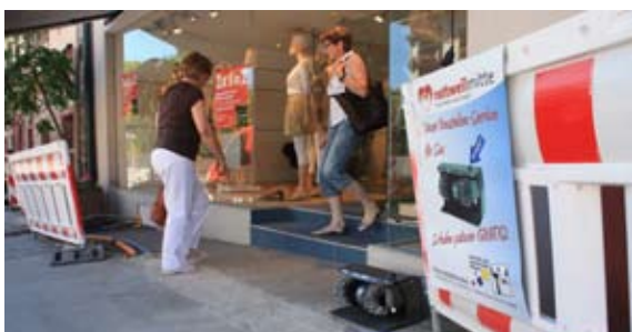
Ersatzleitungen wurden kundenfreundlich verlegt
