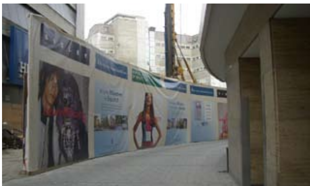
Bauzaun als Werbefläche, München
