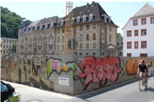
Gestalteter Bauzaun mit Graffiti und Schaulöchern
