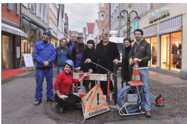
Baustelleneinrichtung mit OWIgut-Verantwortlichen
