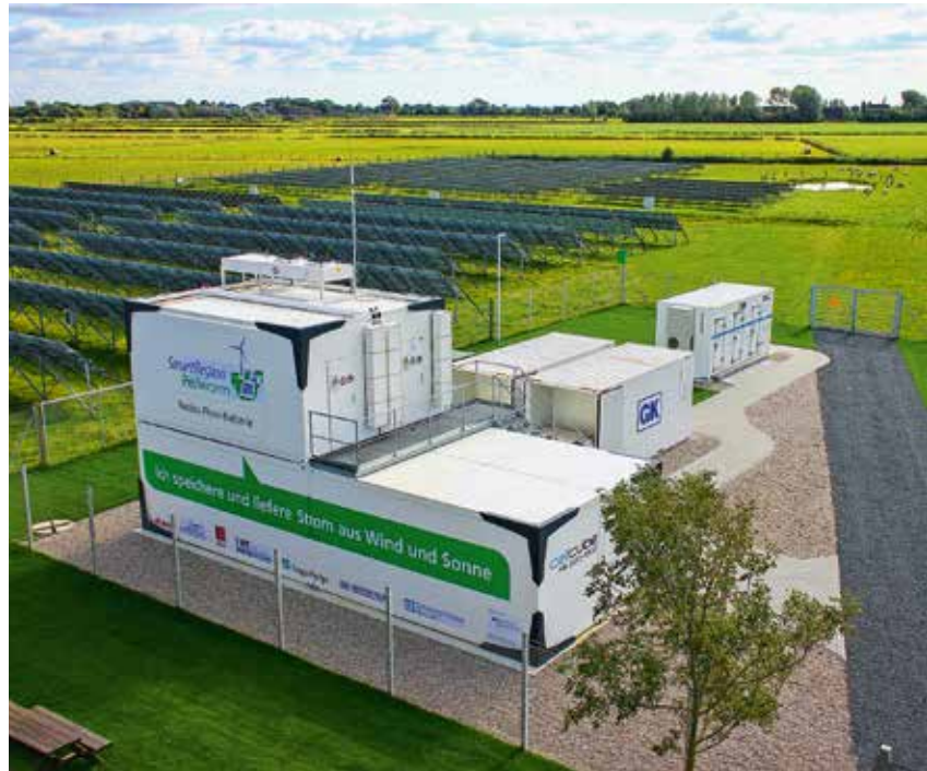
Kern der „Smart Region Pellworm“: Hier wird Strom aus Wind und Sonnenkraft gewonnen und gespeichert.
