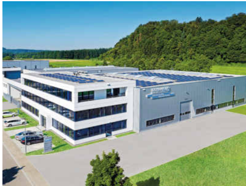
Das neue Gebäude von Schilling Engineering wurde in einer Bauzeit von nur einem halben Jahr errichtet.
