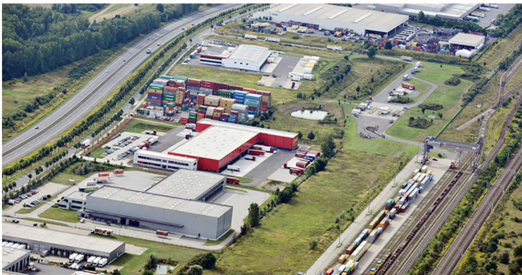
ABB. 11: GVZ BERLIN-SÜD MIT KV-ANLAGE (KOMBINIERTER VERKEHR)
