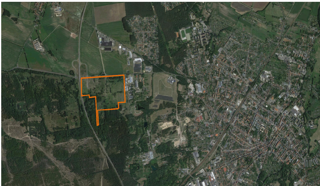
ABB. 64: GEWERBEGEBIET ZAPFHOLZWEG IN LUCKENWALDE (LUFTBILD)
