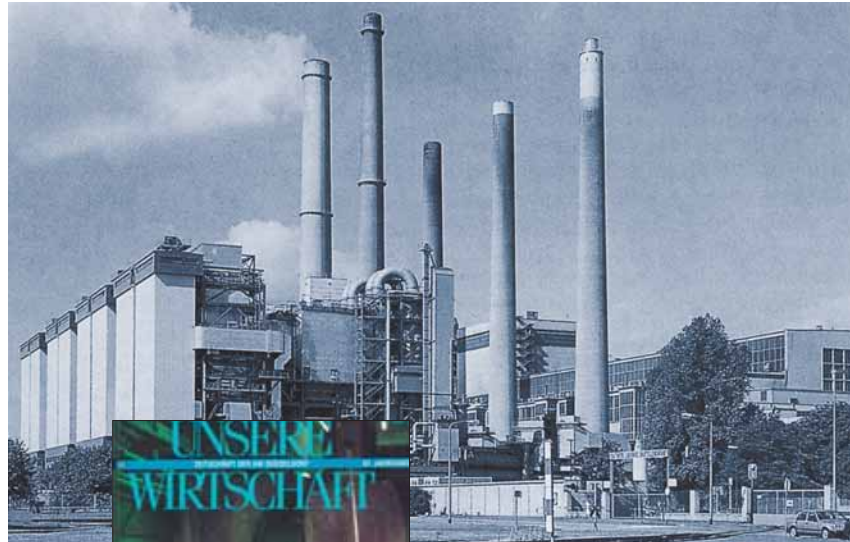
Die Müllverbrennungsanlage in Düsseldorf arbeitet mit einer dreistufigen Rauchgasreinigungsanlage.
