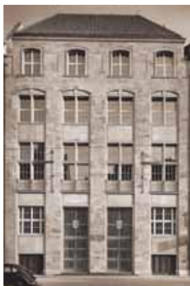
Das nach dem Krieg wieder aufgebaute Gebäude der IHK an der Graf-Adolf-Straße.
