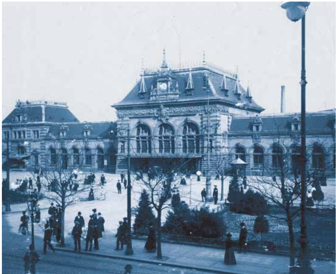
Der neue Hauptbahnhof, eröffnet 1891.
