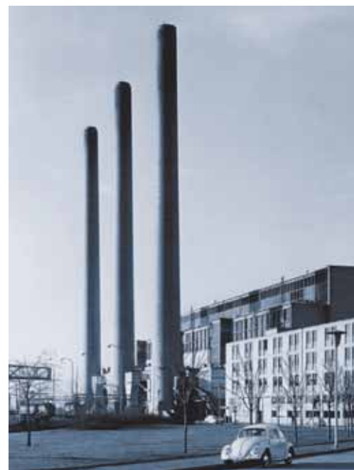
Die IHK setzte sich für den Bau des Kraftwerks Lausward ein.
