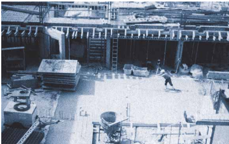
An der Karlstraße in Düsseldorf wurde das neue IHK-Weiterbildungszentrum „FORUM“ gebaut.
