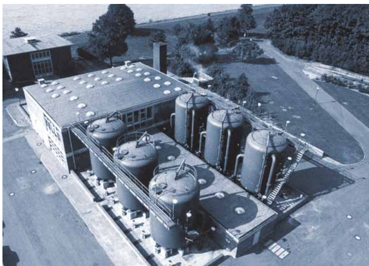
Die Wasserversorgung rückte in den 1950er Jahren in den Fokus des Interesses. Im Bild das Wasserwerk Flehe.
