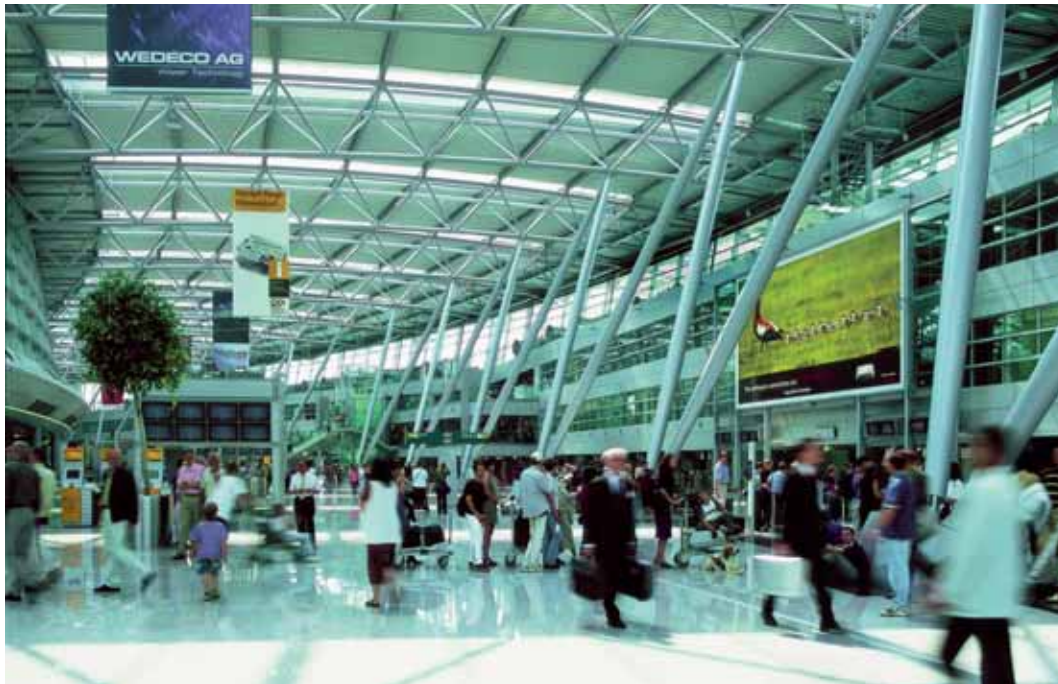
Die Abfertigungshalle des Flughafens Düsseldorf International heute.
