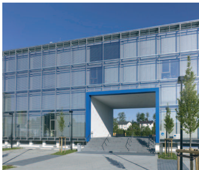
Das Business + Innovation Center bietet Raum für innovative Ideen und aktuelle Gründungsvorhaben.
