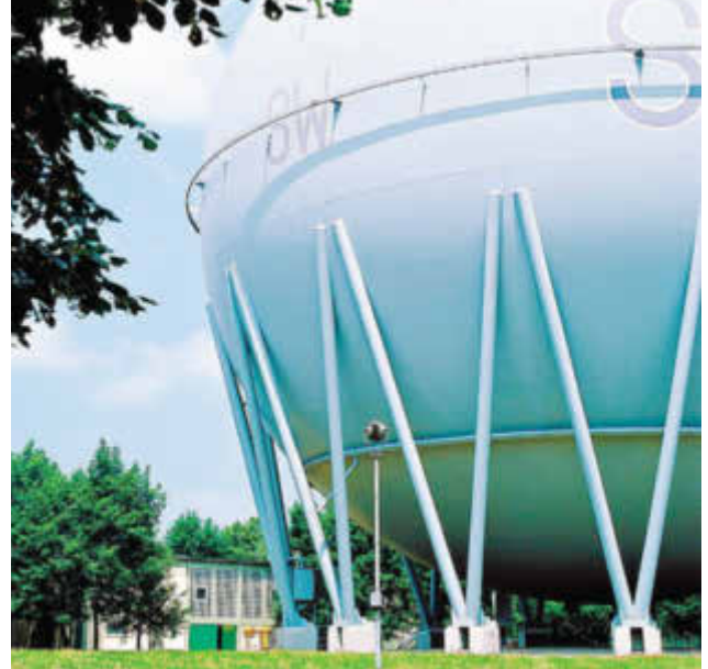
Die Erdgaskugel in Freiburg-Betzenhausen gehört der Badenova.
