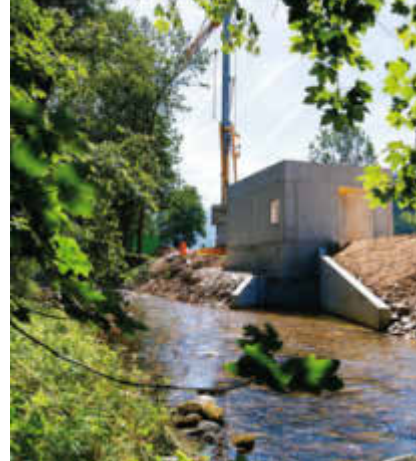
Das neue Wasserkraftwerk im Neumagen – im Vordergrund der Auslauf.
