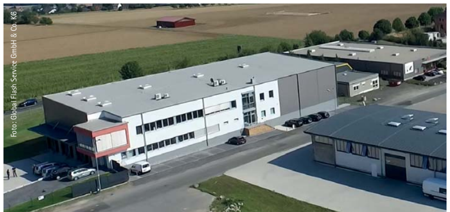
Luftaufnahme des neuen GFS-Gebäudes.
