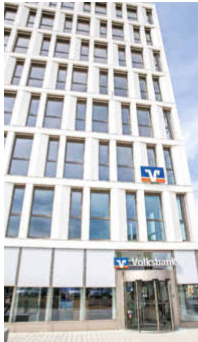
Eine Filiale der Volksbank ist in die Freiburger Westarkaden (Bild) umgezogen, drei Filialen sollen in diesem Jahr geschlossen werden.
