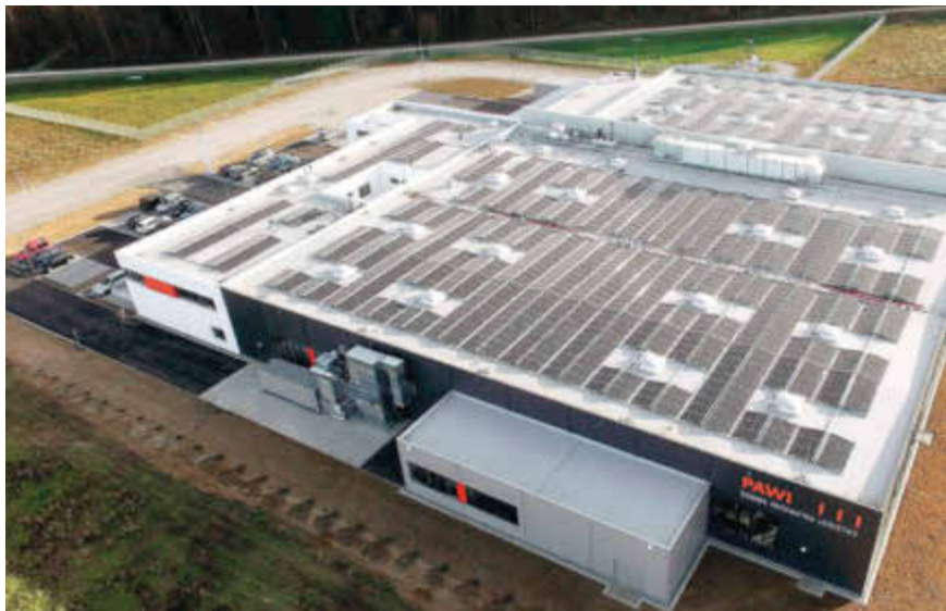
Das Faltschachtelwerk in Singen ist mit neuester Technologie ausgestattet.
