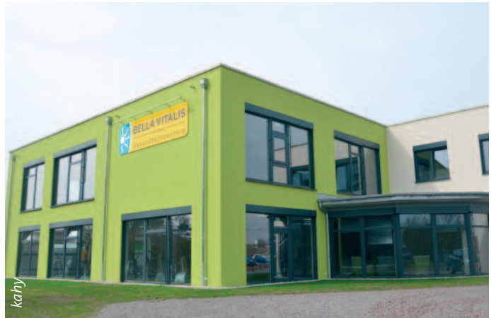
Das neue Bella Vitalis Gesundheitszentrum überzeugt mit großzügigen Trainingsräumen sowie modernen Farben und Materialien.
