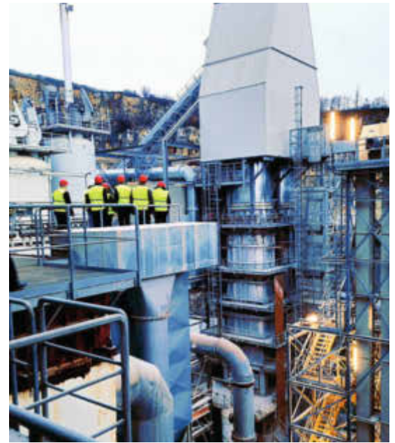
Der Energie- und Umweltausschuss und der Industrieausschuss tagten beim Kalkwerk in Istein.
