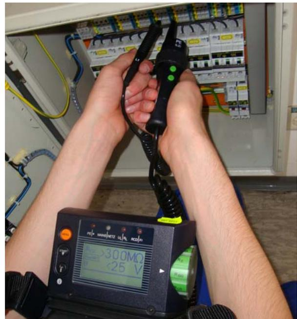
Abb. 1<sup>1)</sup>: Wiederholungsprüfung an einer elektr. Anlage
