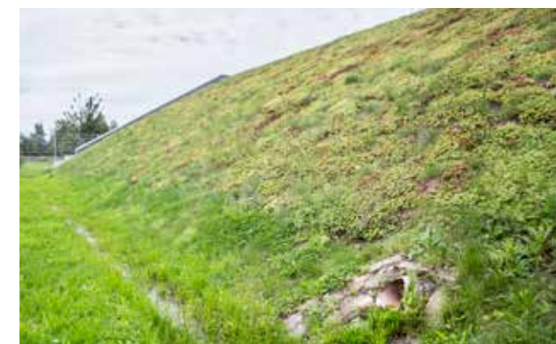
Foto oben Das aufsteigende Gründach mit dem Entwässerungssystem
