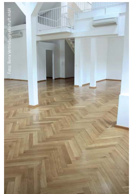
Das versiegelte Parkett des Sieger-Objekts „Villa Möhlstraße“ besticht durch eine tolle Optik.
