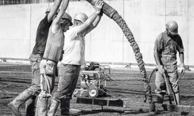
Arbeiter beim Schütten der Beton-Sohle für die Experimentierhalle „Petra Ost“ (links) und Schutzgas-Schweißarbeiten an einem Beschleunigermodul im zukünftigen „European XFEL“ beim Deutschen Elektronen-Synchrotron DESY in Hamburg.
