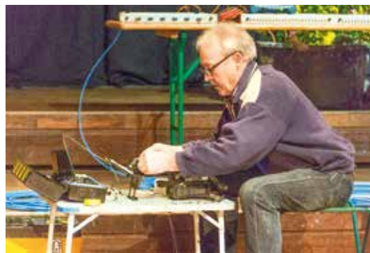
Baustellenatmosphäre: Kabelspleißer Günter Wiegert
