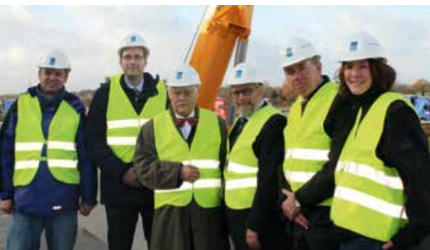
Janina Neumann, Jan Stübinger (zweiter von links), Jan Kinser (links), Michael Legband (dritter von links), Lutz Kirschberger (dritter von rechts) und Diplom-Ingenieur Markus Röttschke (zweiter von rechts) besichtigen die Baustelle Eichhofpark.
