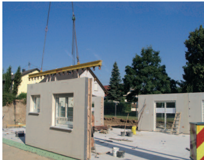
Bauen in der Hälfte der Zeit: Das patentierte Wallfit-Verfahren von öko-domo eignet sich für Wohnhäuser ebenso wie für Zweckbauten, zum Beispiel eine Kita, die schnell bezugsreif sein muss.
