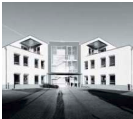
Kanzleigebäude in der Hans-Wunderlich-Straße 5 in Osnabrück
