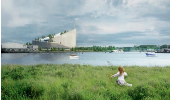
Müllkraftwerk Amager Bakke
