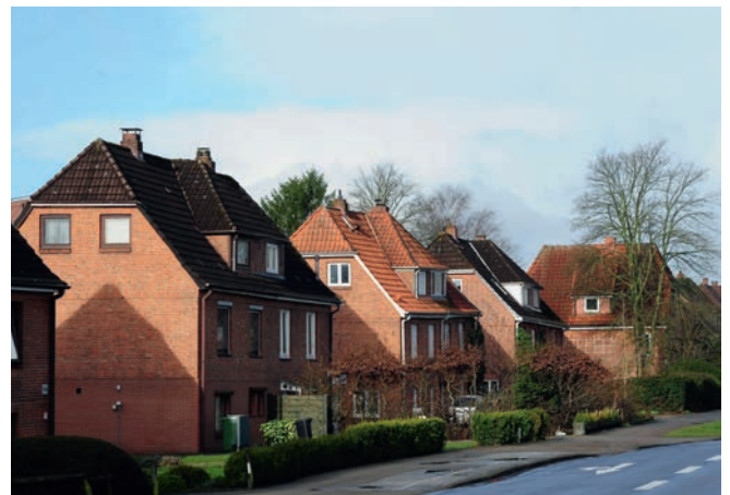
Siedlungshäuser in Nettelburg
