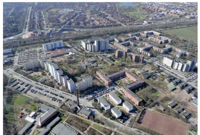
Wohnhochhäuser in Bergedorf-West
