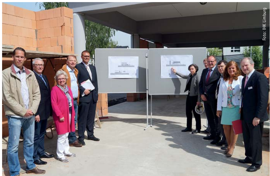
Architektin Gisela Schwarz (Mitte) erläutert auf der Baustelle dem Bauausschuss der IHK Limburg die bisherigen und zukünftigen Baumaßnahmen zur Erweiterung des IHK-Gebäudes.
