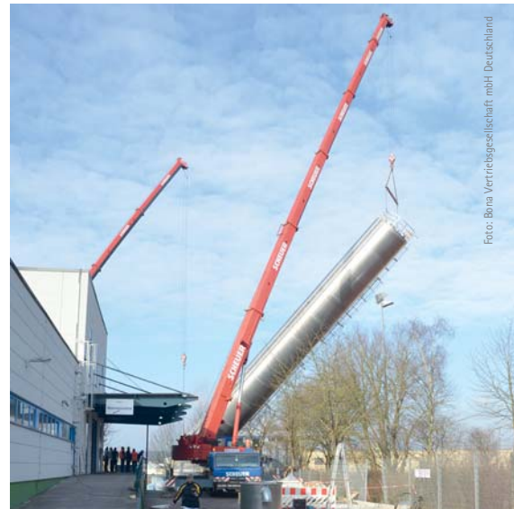
Das Silo mit einem Durchmesser von 3,5 Metern wurde von zwei Autokränen auf einem 4,5 x 4,5 Meter großen Fundament aufgestellt, das mit acht speziellen, elf Meter langen Kleinverpresspfählen tief im Boden verankert wurde.
