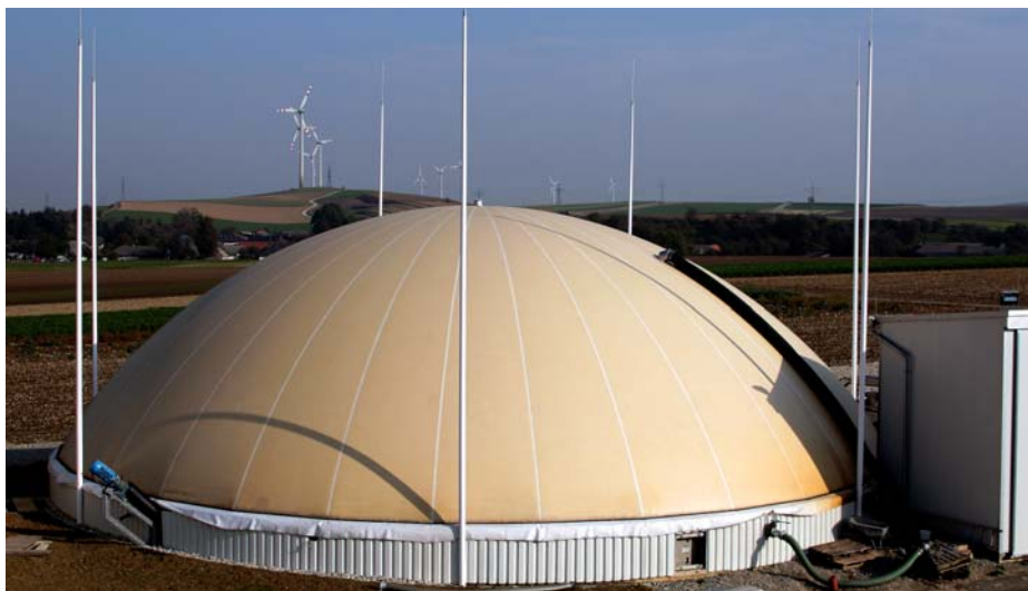
Biologische Abfälle verwerten: Biogas-Anlage
