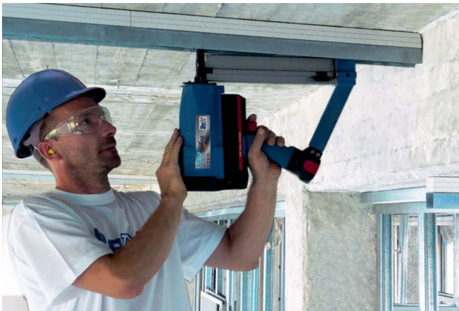
Der gasbetriebene Nagler Dynamik CN60 von BeA im Einsatz
