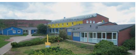
Foto: Architekten- und Ingenieurkammer Schleswig-Holstein
