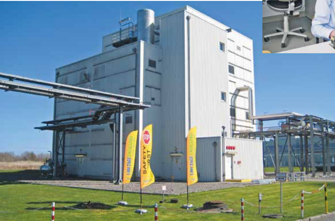
Industrieanlage auf dem Gelände der CP Kelco Germany GmbH
