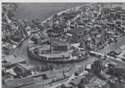
Luftaufnahme der Zuckerraffinerie Itzehoe, ca. 1950/60.
