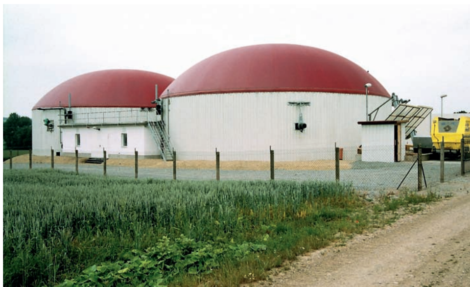
In solch einer Anlage wird Biomasse in Biogas umgewandelt.
