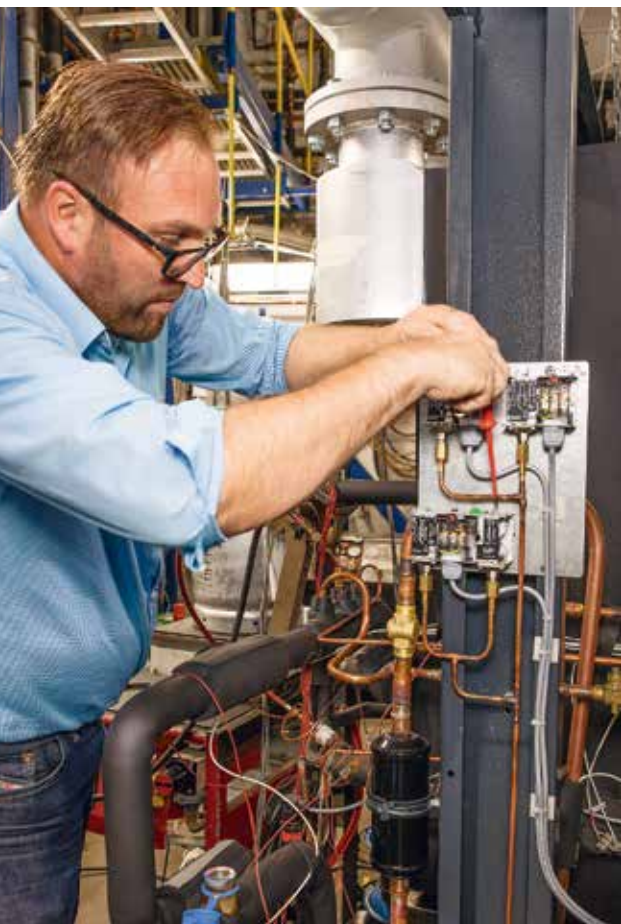
Spezialisten fertigen die industriellen Drucklufttrockner
