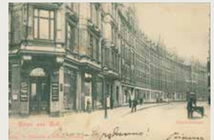
Die Ecke Holtener-/Preußerstraße vor der Errichtung des Jacobsen-Warenhauses um 1908.
