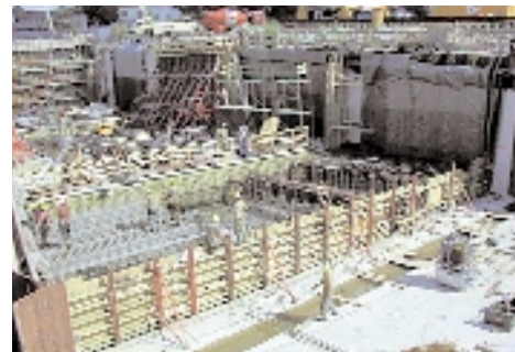
Das Jahrhundertbauwerk: der Hemelinger Tunnel
