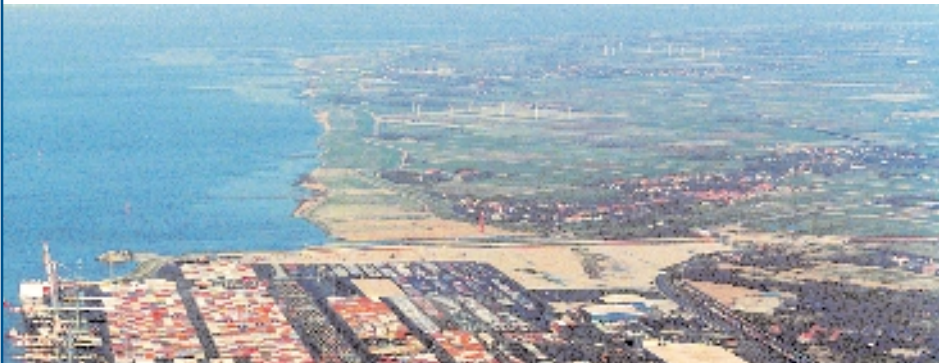
Die Containerterminals CT IIIa und CT IV müssen zügig ausgebaut werden, damit die Bremischen Häfen weiter an der positiven Entwicklung der Weltcontainerschifffahrt partizipieren können.
