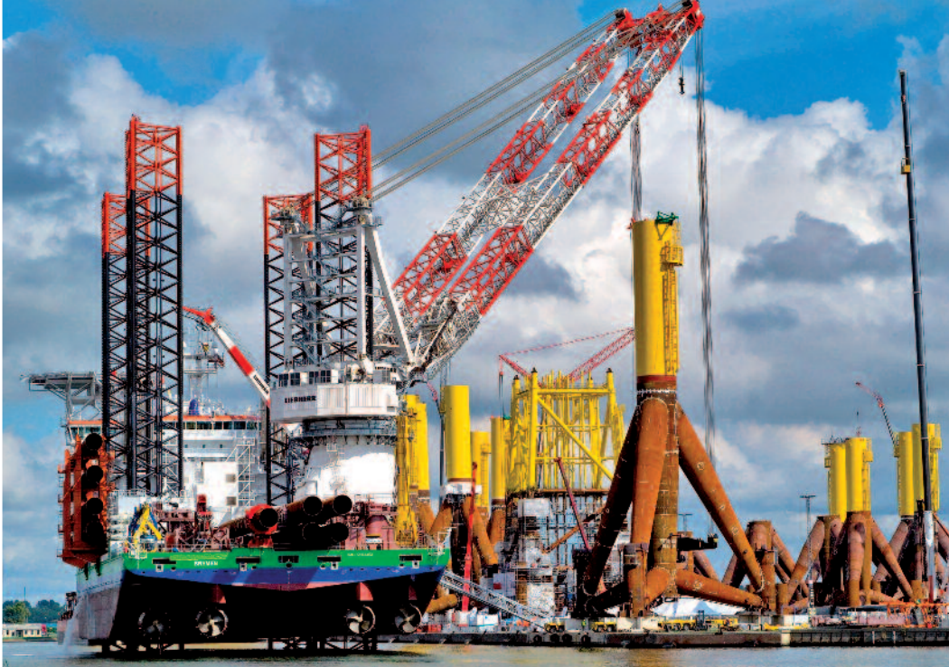
Kranhubschiff für die Offshore-Installation: Areva Wind setzt das Spezialschiff ( Innovation ) ein, um Windenergieanlagen auf hoher See zu transportieren.
