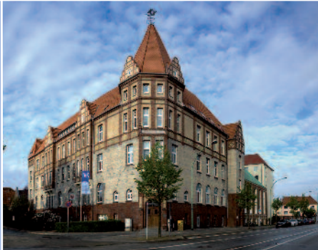
Saniert und restauriert: Gebäude der IHK in Bremerhaven
