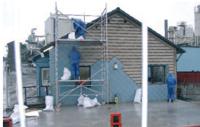
Wicke ist Spezialist für die Entfernung von asbesthaltigen Baumaterialien.
