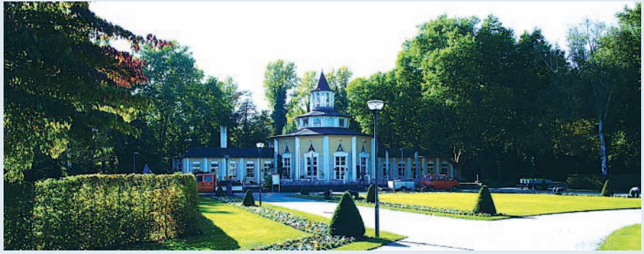
Wird umfassend saniert. Das Turmrestaurant im Ludwigshafener Ebertpark.
