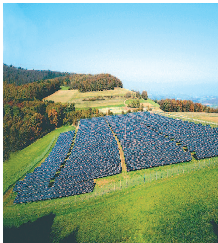
Die schlüsselfertige Errichtung von Solarparks ist ein wichtiges Standbein von Eurosol.
