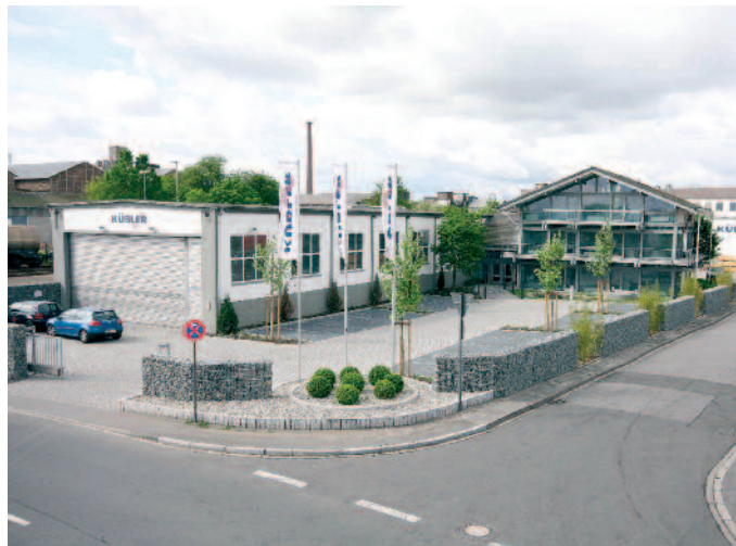
Firmsitz der Kübler GmbH, dem Spezialisten für energiesparendes Heizen
