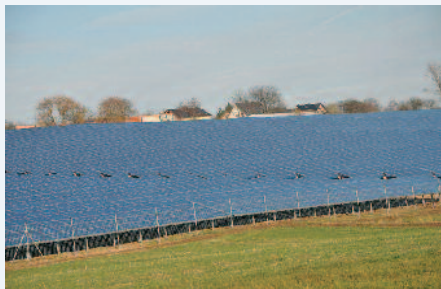
Der neue Solarpark vermeidet rund 3.000 Tonnen CO2 pro Jahr.
