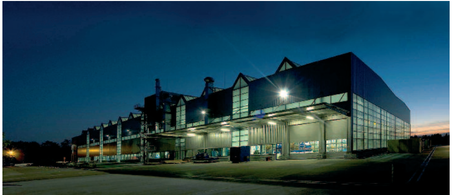
In dieser modernen Produktionshalle entstehen große Kraftwerkspumpen.
