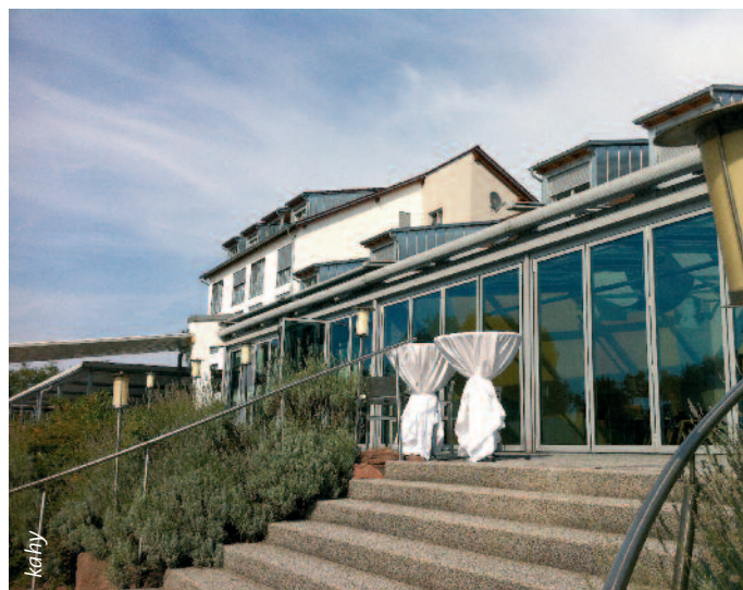
Das Hotel Darstein in Altrip präsentiert sich nach aufwändigem Umbau mit völlig neuem Gesicht.
