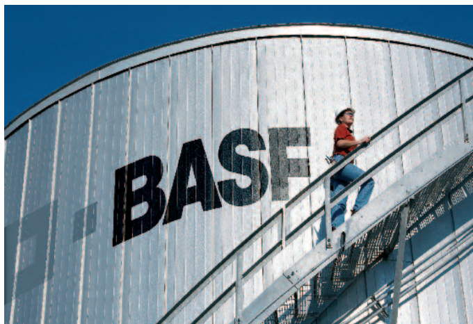
Ein Speichertank in Freeport, Texas
