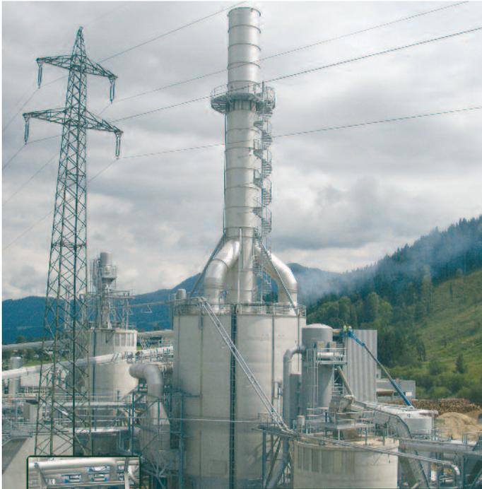
Mit einem Nasskohleelektrofilter können Feinstäube u. ä. abgeschieden werden.
