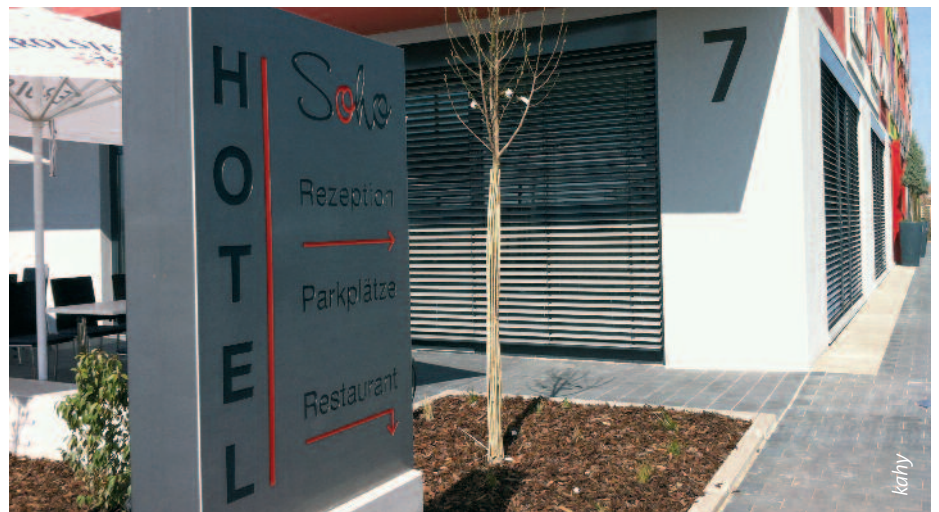
Steht künftigen Gästen jetzt offen – der Neubau.
