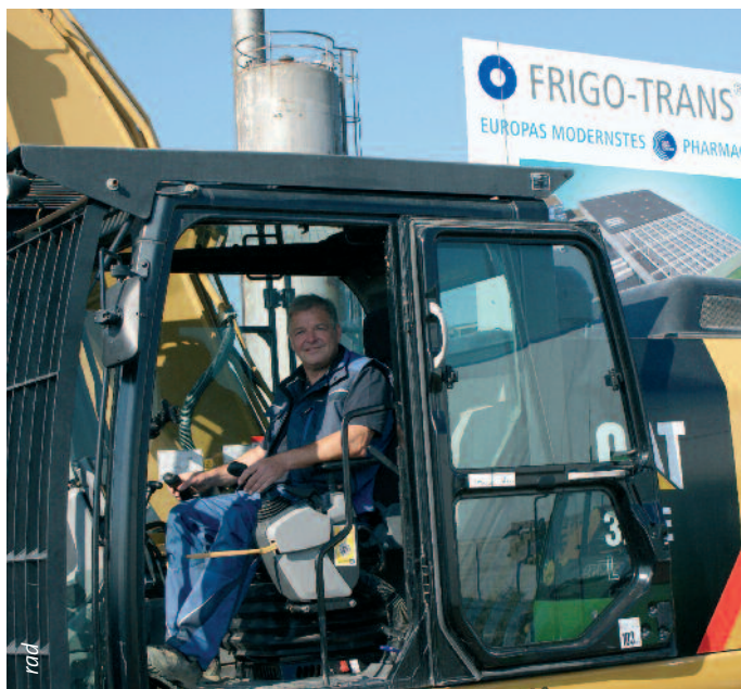
Logistiker aus Leidenschaft: Geschäftsführer Peter Norheimer packt bei den Bauarbeiten auch selbst mit an.
