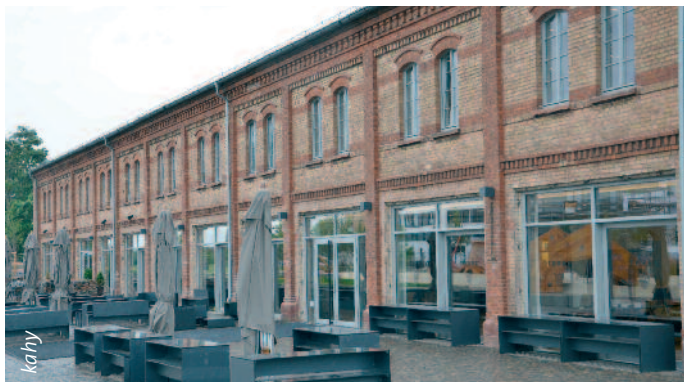
In neue Räume in einer sanierten Kaserne in Landau-Süd ist die junge Kommunikationsagentur „Mark Lotse“ eingezogen.
