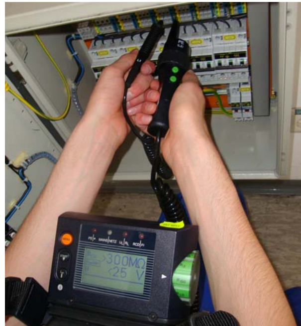
Abb. 1 1) : Wiederholungsprüfung an einer elektr. Anlage
