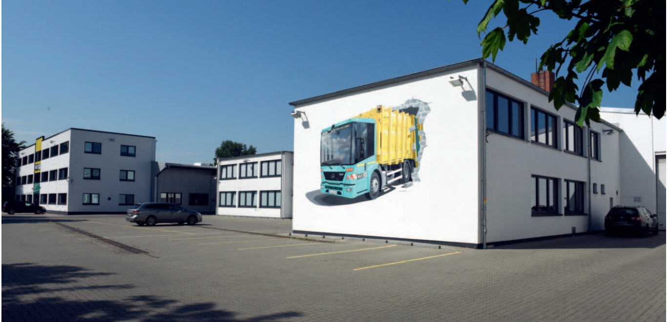
Energieeffiziente Bürogebäude und Hallen nach kompletter Sanierung auf dem neuen Betriebsgelände.
