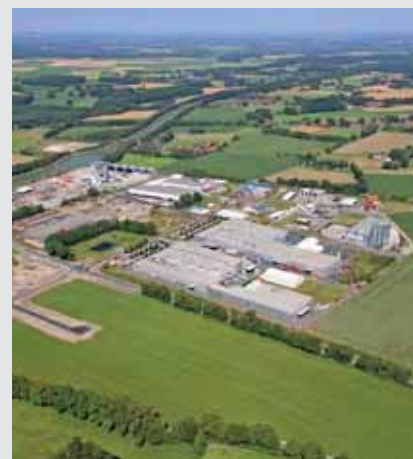
Das Gewerbegebiet westlich der L 78
