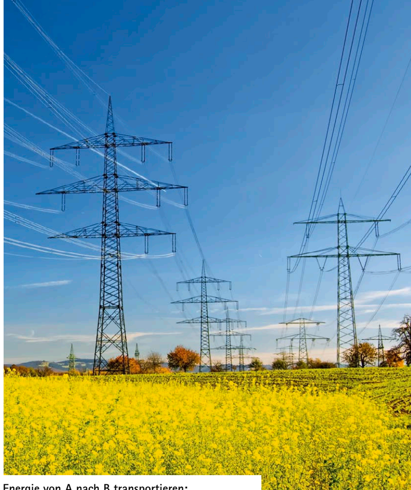
Energie von A nach B transportieren: Viele Leitungen verlaufen heute unterirdisch.
