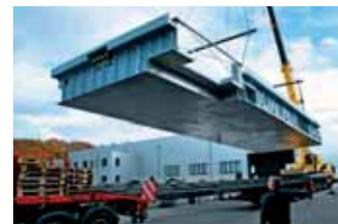
auf den Weg ins Salzburger Land gebracht. Drei Tage Fahrt benötigte das 20 Meter lange Becken, das in Form, Funktion und Ausstattung ein Unikat ist, auf dem Weg zum Besitzer. Dort wird es in einen Hang eingebaut und eine 20 Meter lange Acrylglasscheibe an der abschüssigen Längsseite wird den Blick auf das Tal freigeben. Das Wasser soll dabei über die Scheibe überlaufen.
