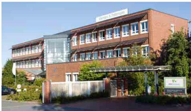
Praktisch: Die Beschattungen vor den Büros nutzen zugleich die auftreffende Sonnenenergie.
