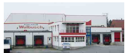
Das Kühlhaus verfügt über 6000 Palettenstellplätze
